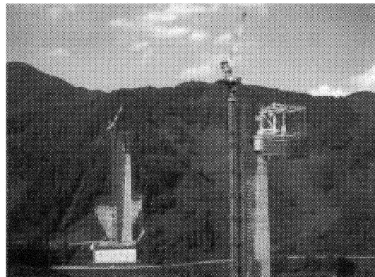
写真-1 架設状況 (手前がP1橋脚)
