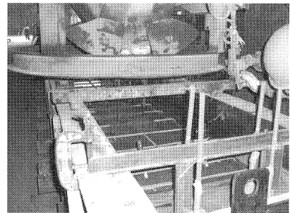
写真-3 打設状況
