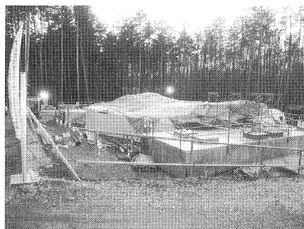
写真-2 底版コンクリート打設前全景・底版コンクリート養生状況
