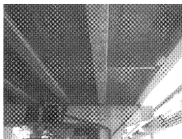
写真-2 施工前写真
