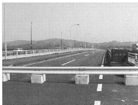
写真-1 着工前全景 (全面通行止め)
