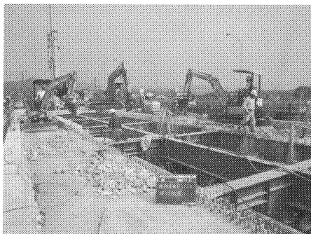
写真－5 合成桁部 床版撤去状況
