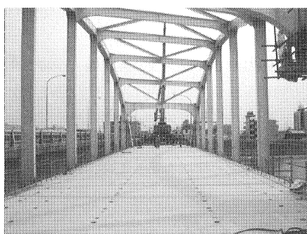
写真-4 床版設置完了全景
