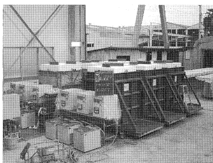
写真-1 構造体温度養生状況
