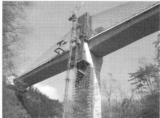
写真-1 施工中の9号橋
