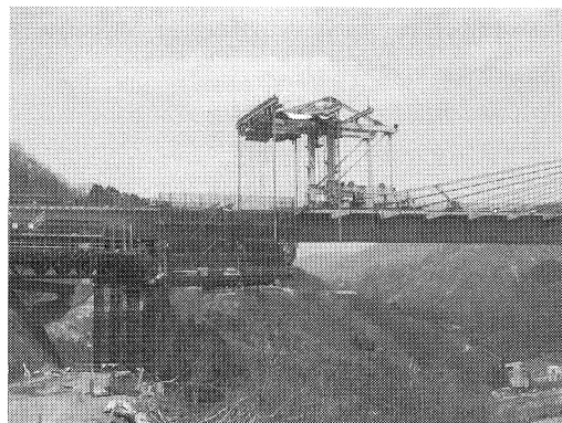
写真-3 側径間部閉合
