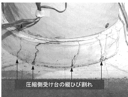
写真-3 圧縮側破壊状況
