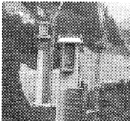
写真-2 柱頭部施工完了
