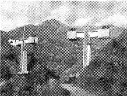
写真-1 張出し施工状況
