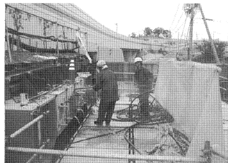
写真-2 目地洗浄状況
