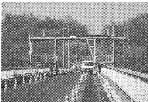
写真-5 作業状況
