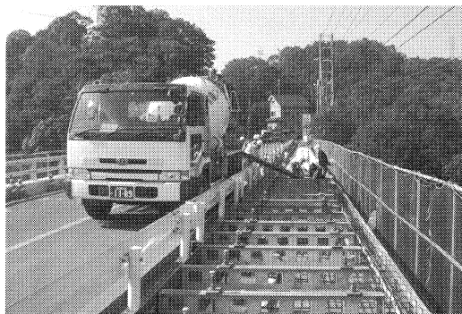
写真-6 コンクリート打設状況
