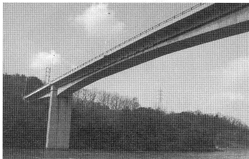
写真-8 工事完了後
