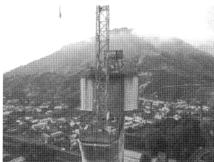
(1) 柱頭部横桁打設
