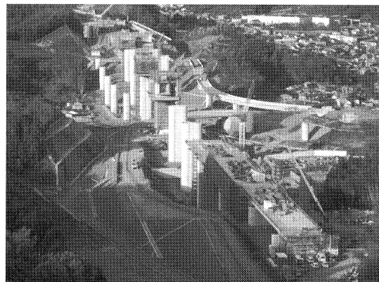
写真-3 施工状況
