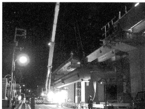
写真-4 主桁架設状況
