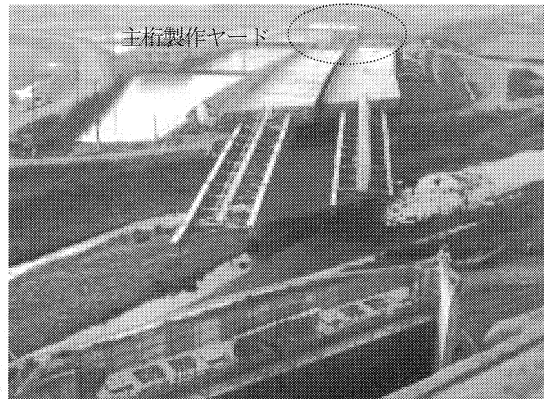
写真-4 押し出し架設状況
