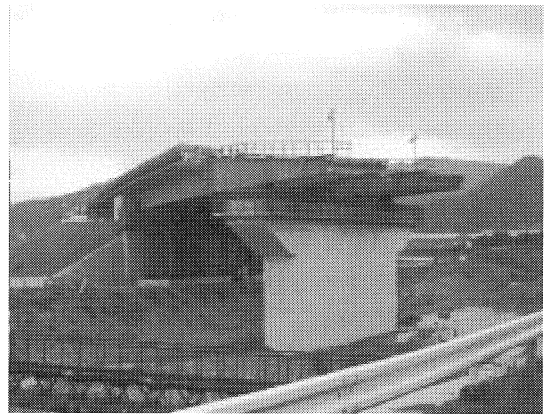
写真-1 押し出し架設状況（分散式）
