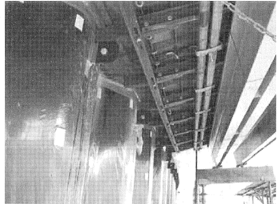
写真-5 上床版型枠
