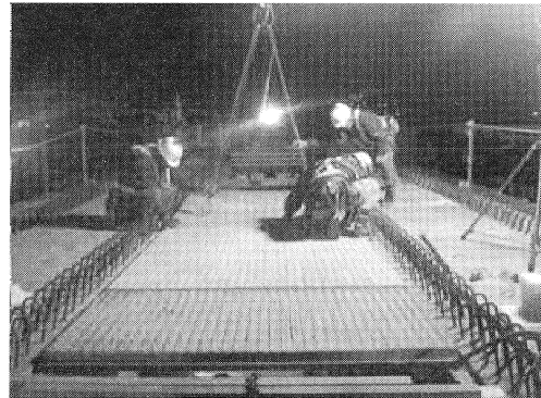
写真-3 PC板架設状況
