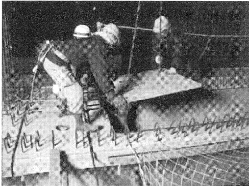
写真-2 RC板架設状況
