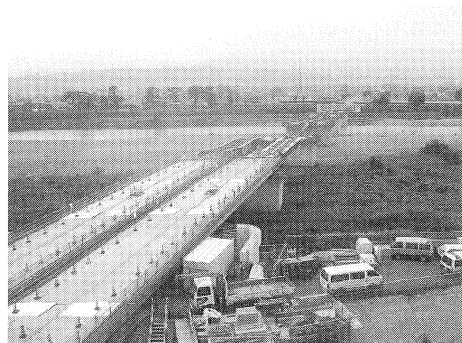
写真-2 押し出し架設状況
