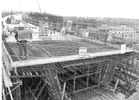
写真-2 内部支保工
