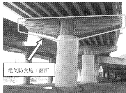
写真-4 陽極システム取付け完了
