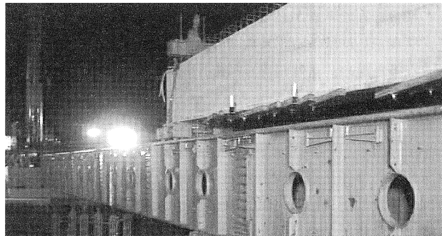
写真-4 主桁架設状況
