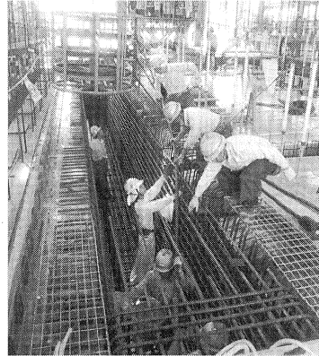
写真-3 ケーブル挿入状況
