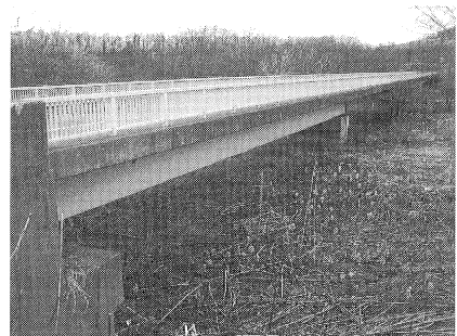
写真1 調査対象橋梁
