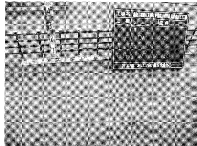
写真-12 縁石鉄筋組立状況
