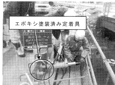
写真-10 緊張状況
