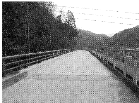
写真-1 3期施工部完成写真
