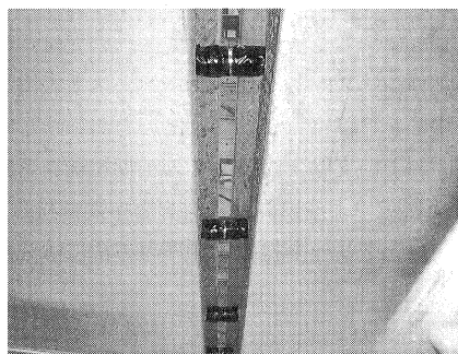
写真-5 シース取付状況
