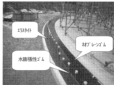
写真-1 支承材敷設完了
