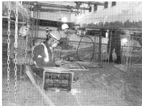
写真-2 緊張作業状況 (泉橋)
