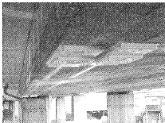
写真-1 炭素繊維プレートの設置状況 (調布高架橋)
