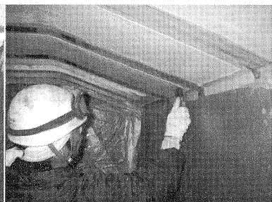
写真-6 シート端部処理
