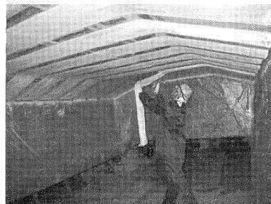
写真-5 シート貼り付け
