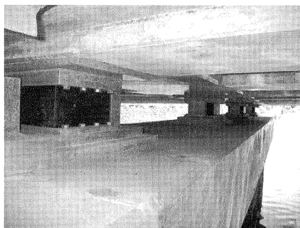
写真-5 免震支承(仮受け設備撤去後)
