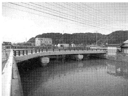
写真-6 完成(上流側から)
