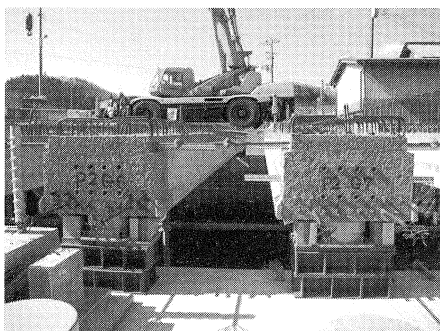
写真-4 主桁仮受け状況
