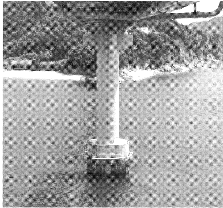
写真-2 P2橋脚
