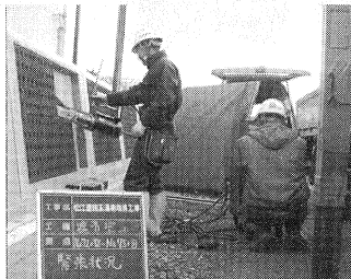
写真-7 PC鋼材緊張
