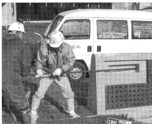
写真-5 PC鋼材挿入
