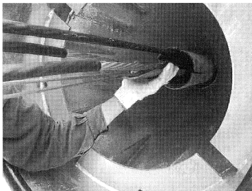
写真-5 シャトルへのストランド接続
