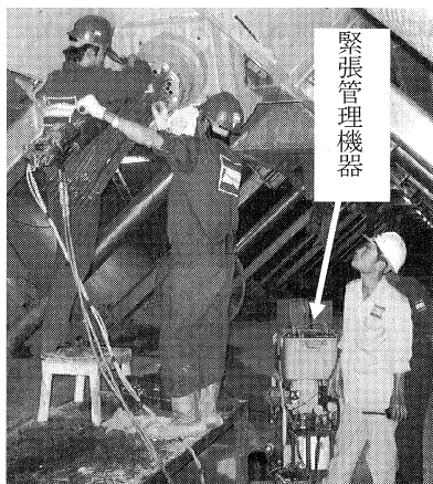
写真-4 斜ケーブル緊張状況
