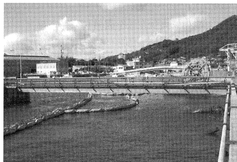
写真-7 完成状況
