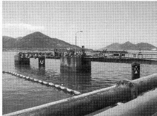
写真-1 既設栈橋状況
