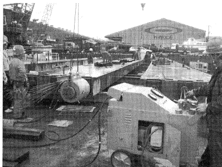
写真-4 緊張作業状況
