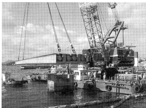
写真-5 主桁架設状況
