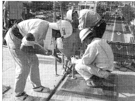
写真-7 ウェットジョイント部打設
