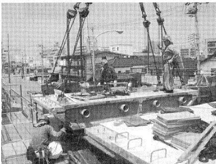
写真-4 柱頭部セグメントの設置
