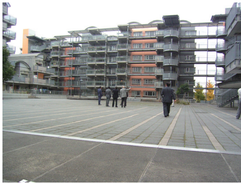
船越教授(東京電機大学)とパートナーによる設計、アイソレータ 242 台を使用。
