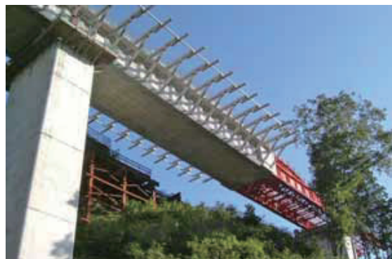
写真-3 桂島高架橋
