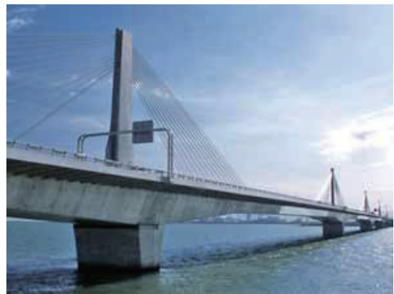
写真-1 揖斐川橋
