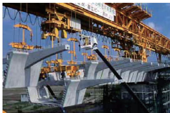
写真-4 古川高架橋
