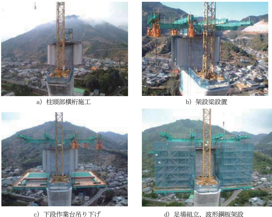
写真-1 柱頭部施工状況
