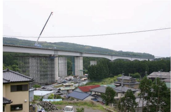
写真-1 赤淵川橋全景
