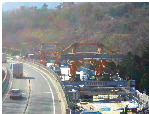
写真-1 張出施工
