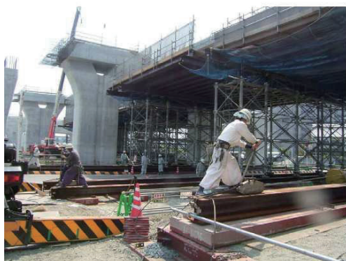
写真-5 横取り状況
