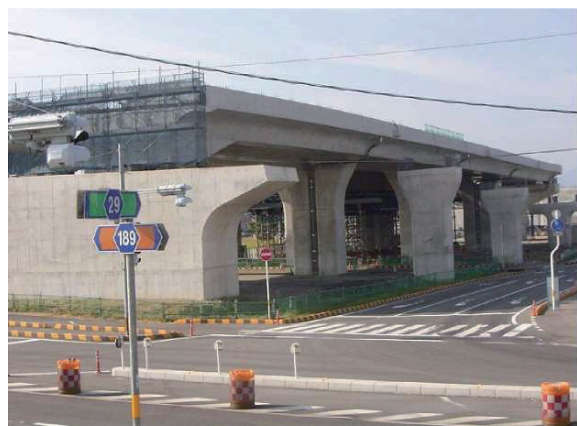
写真-7 完成状況
