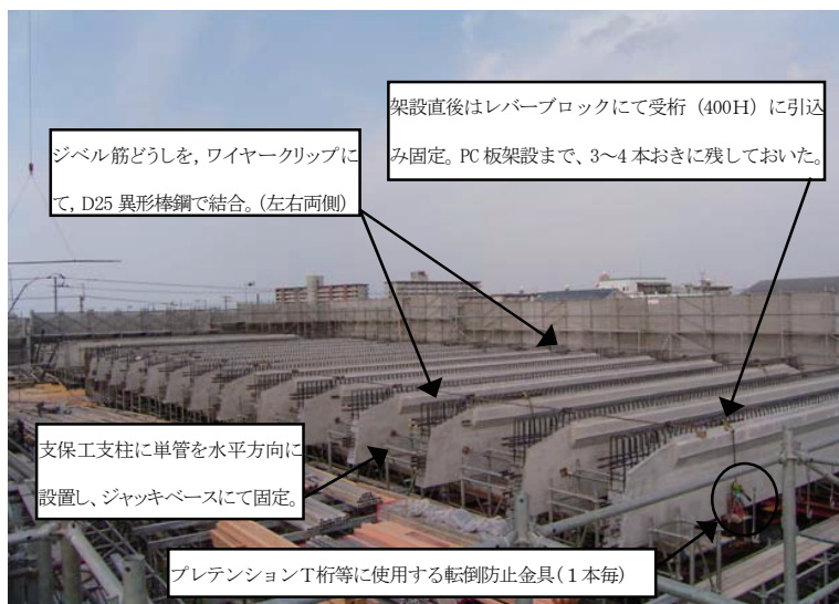
写真-5 横リブ転倒防止対策
