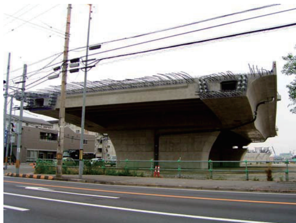
写真-1 工事完了全景
