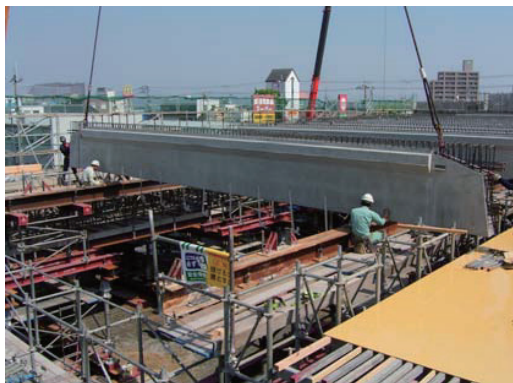
写真-4 横リブ架設状況
