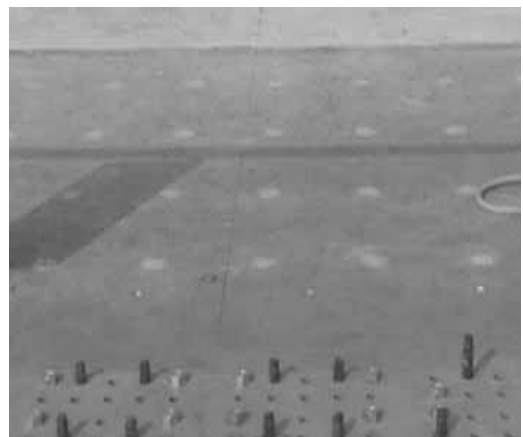
写真-3 排出口後処理状況
