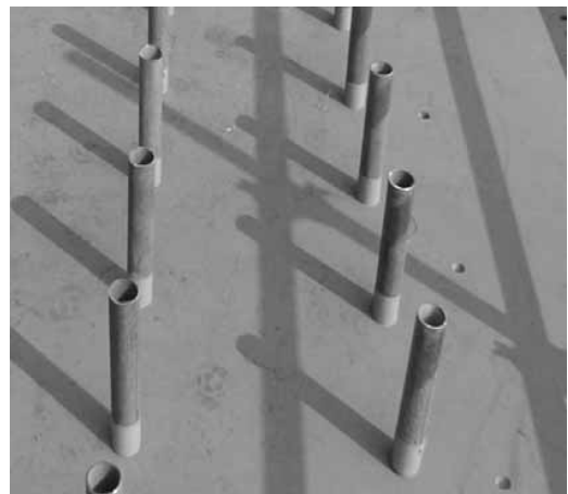
写真-2 排出口設置状況
