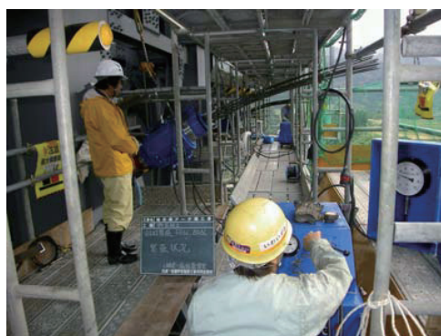
写真-2 斜吊材緊張状況
