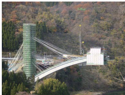
写真-1 斜吊材架設状況
