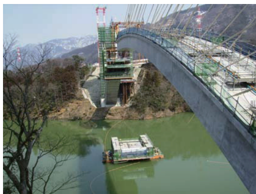
写真-3 トラベラーリフトダウン
