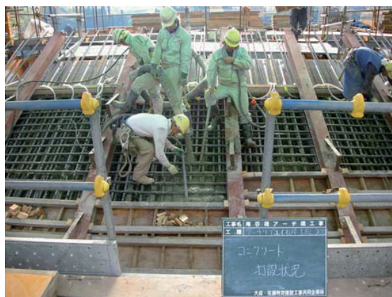
写真-4 コンクリート打設状況
