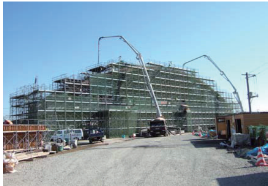
写真-3 アーチリブ打設状況
