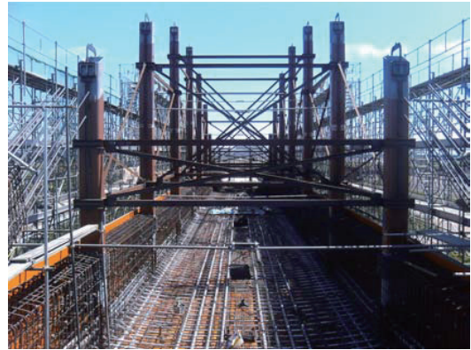
写真-2 鉛直材設置状況
