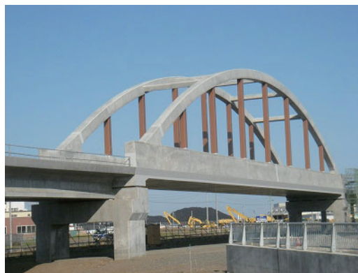
写真-1 星が浦海岸通架道橋完成写真
