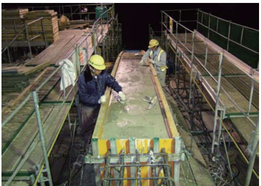
写真-4 アーチリブ仕上げ作業状況
