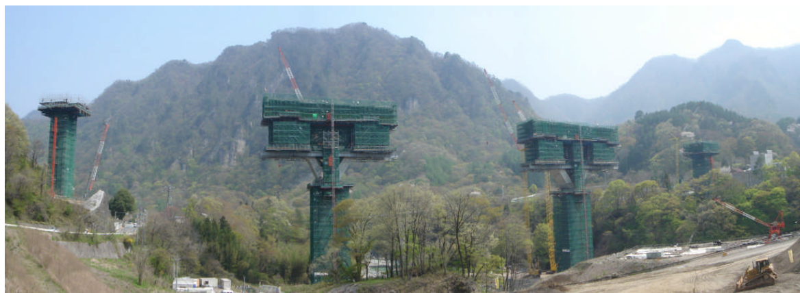
写真-2 施工状況
