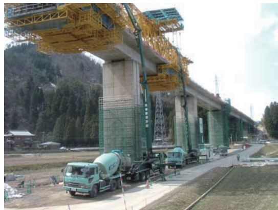
写真-7 ポンプ車2台による起終点同時施工状況
