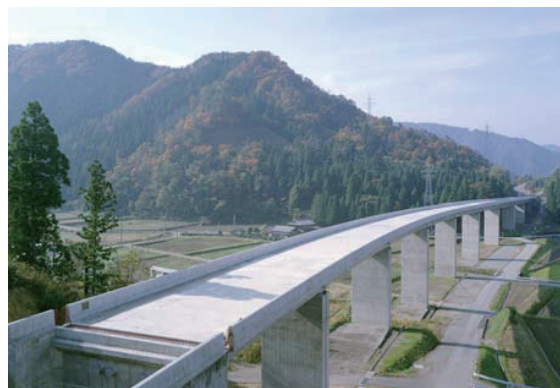
写真-8 施工完了状況（全景）
