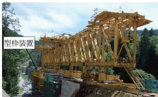
写真-3 P&Z 装置による 1BL 施工状況
