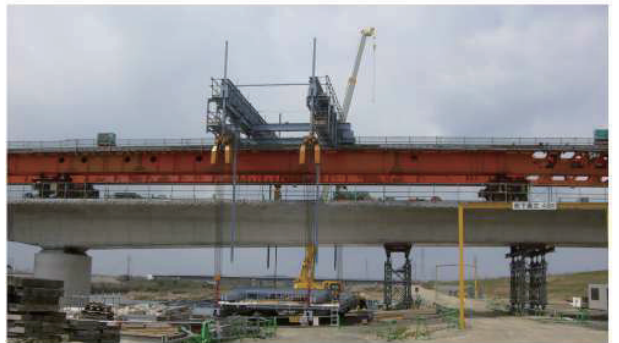
写真-4 仮支柱設置状況
