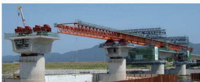
写真-1 張出し架設状況
