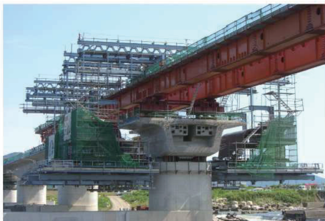
写真-2 作業台開放・橋脚通過状況
