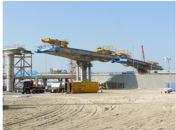
写真-1 バランスカンチレバー架設
